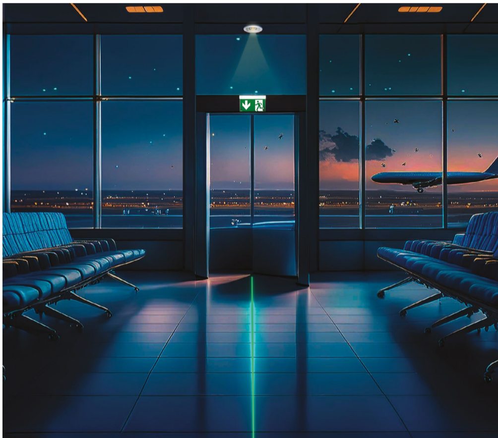
Esemplificazione di posizionamento della Strip LED a terra per evidenziare la via di esodo verso l'uscita di sicurezza. In questo caso occorre utilizzare un profilo calpestabile idoneo per la Strip LED.
