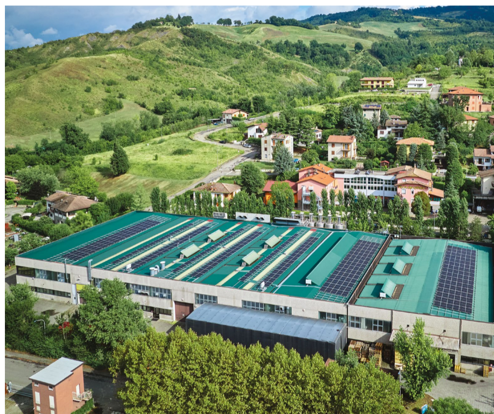
Savigno (BO) - impianto fotovoltaico di 199.470Wp
