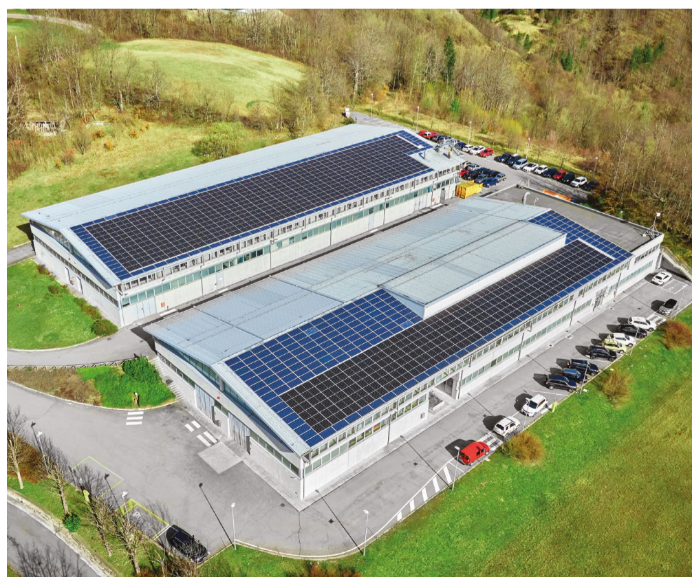
Pievepelago (MO) - impianto fotovoltaico di 287.760Wp
