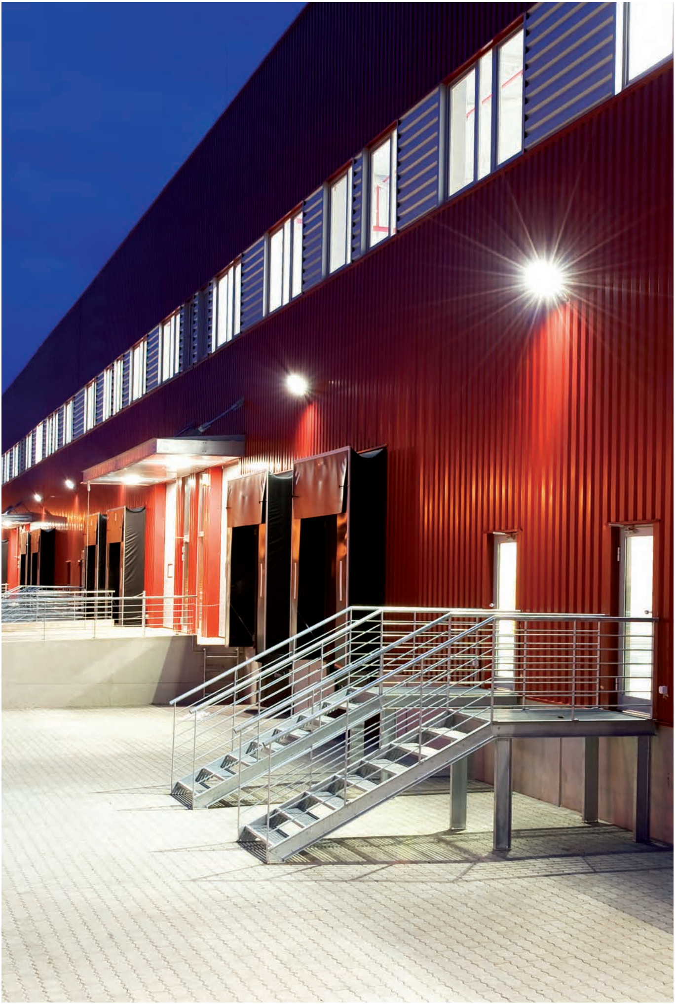
121 proiettori da esterno / outdoor floodlights
