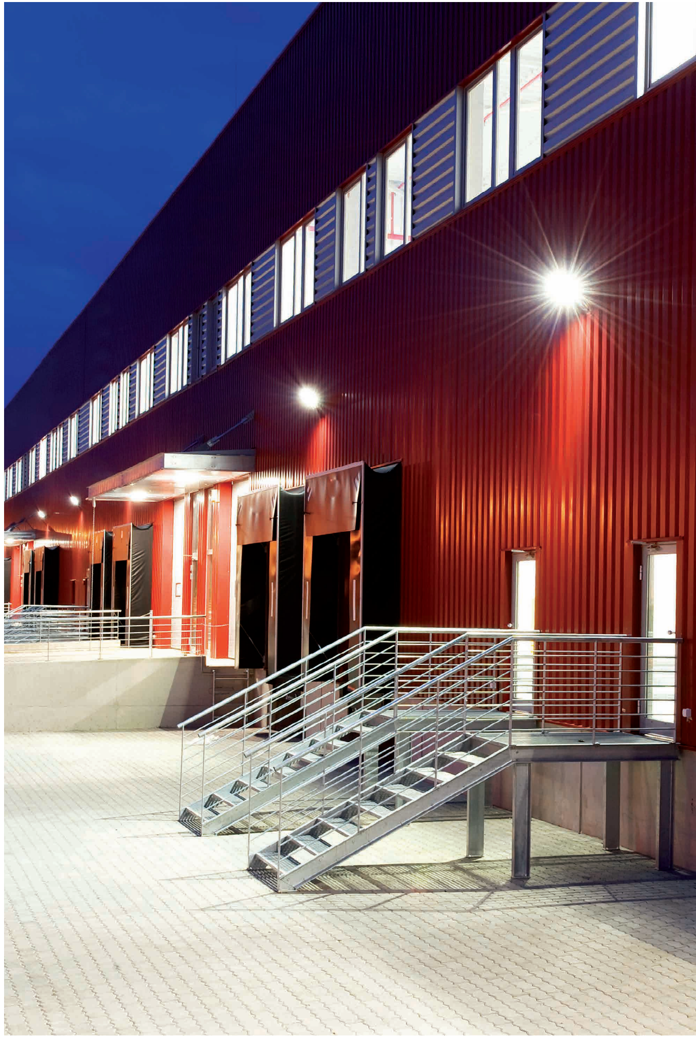
143 venkovní reflektory / outdoor floodlights
