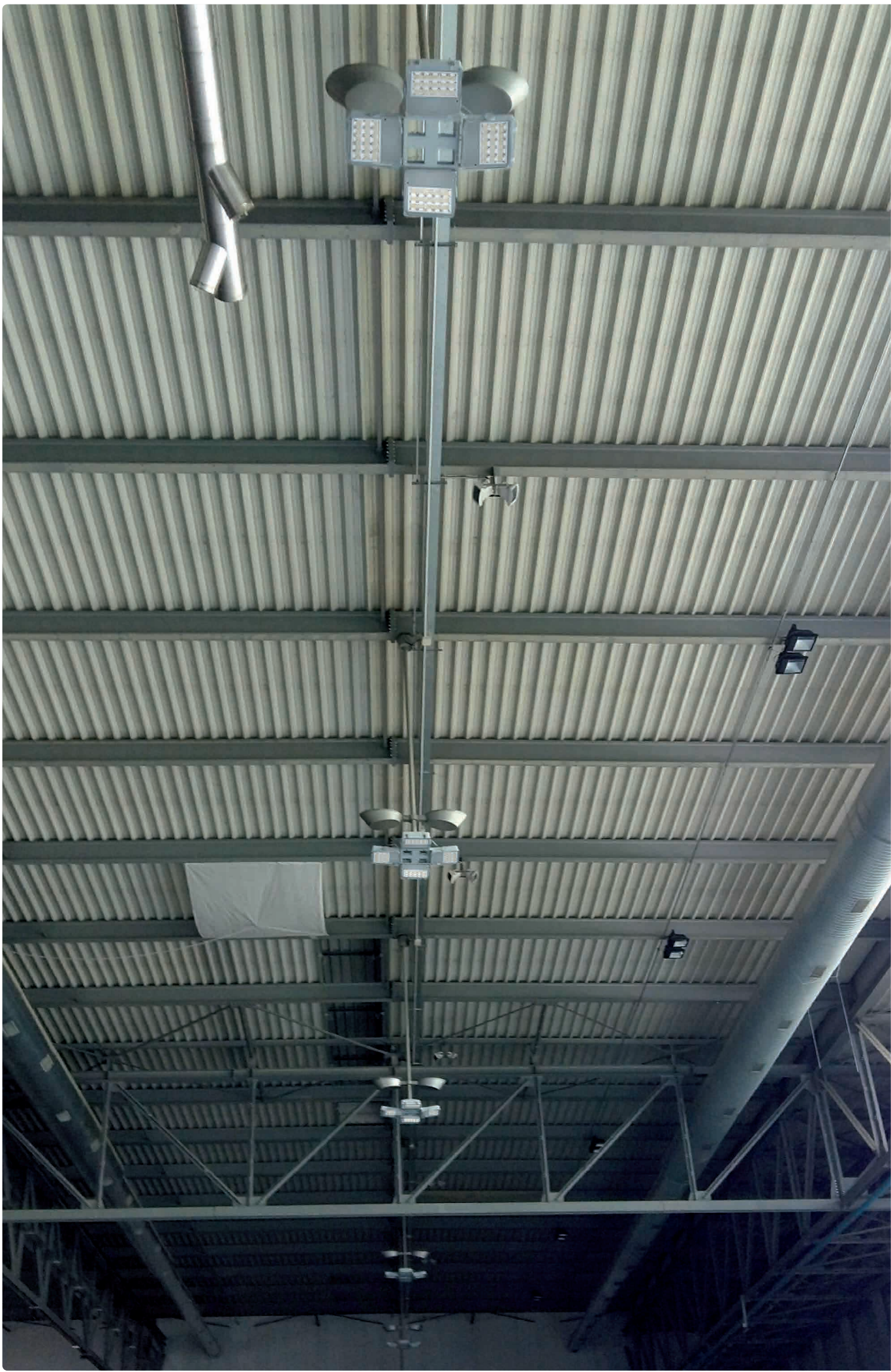
149 venkovní reflektory / outdoor floodlights
