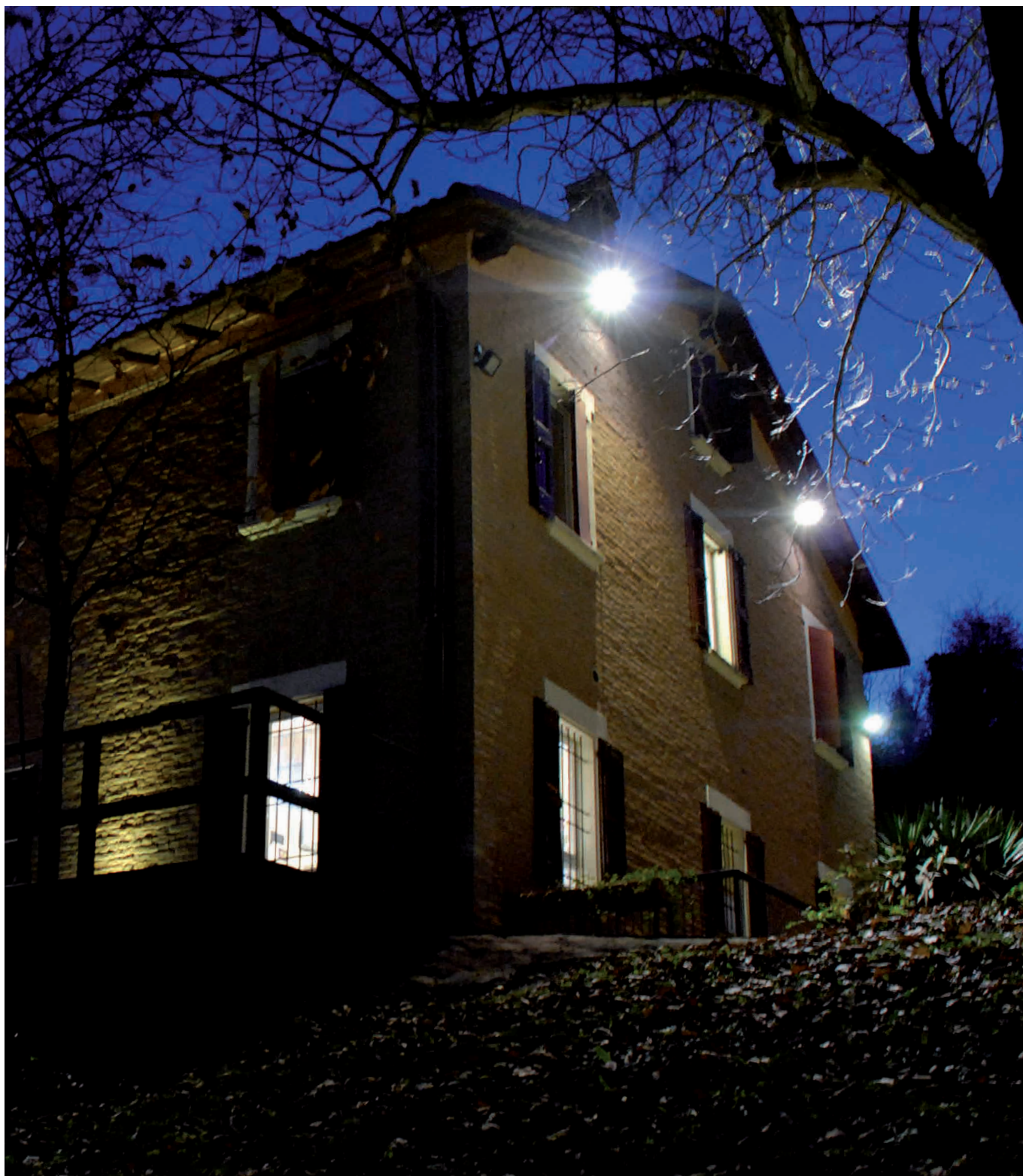
167 venkovní reflektory / outdoor floodlights
